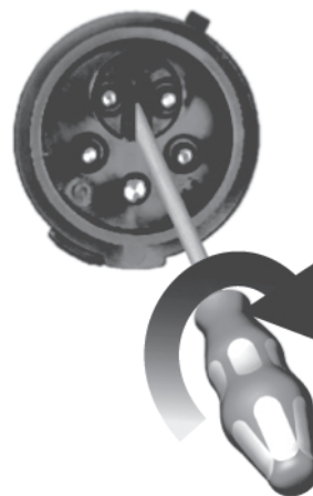
Рис. 14 Смена фаз трёхфазного шкафа управления с фазовым инвертером
