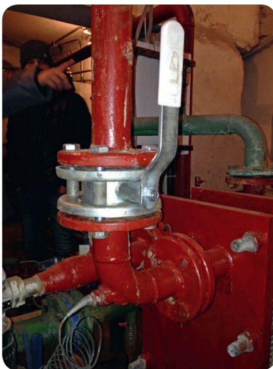
КОНТУР ГВС ПОСЛЕ ПЛАСТИНЧАТОГО ТЕПЛООБМЕННИКА
