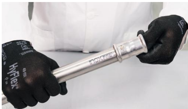
Рис. 31. Вставка трубы в пресс-фитинг.
