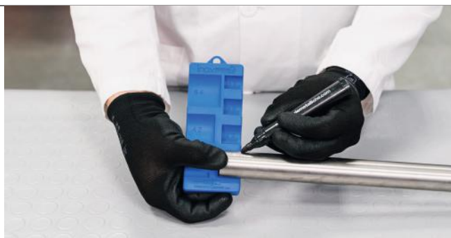
Рис. 28. Маркировка глубины вставки.
