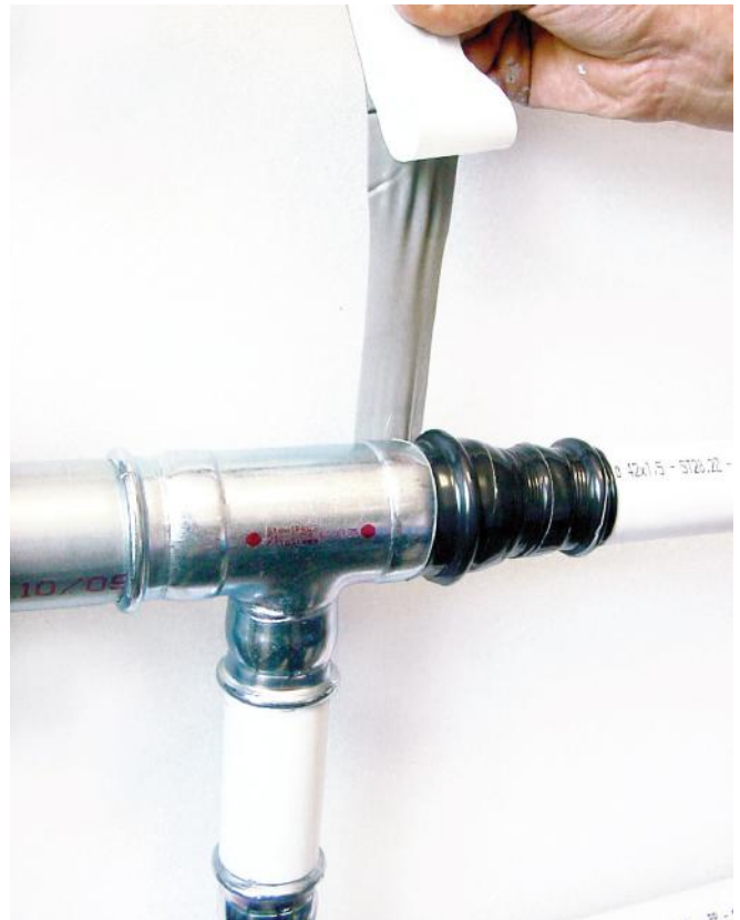
Рис. 38. Защита соединений с помощью бутаноловой клейкой ленты.
