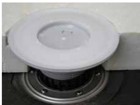
4. Надставной элемент с фланцем (HL85N), подрезанный по толщине утеплителя, вставить в дренажное кольцо (HL180), установить монтажную заглушку.
