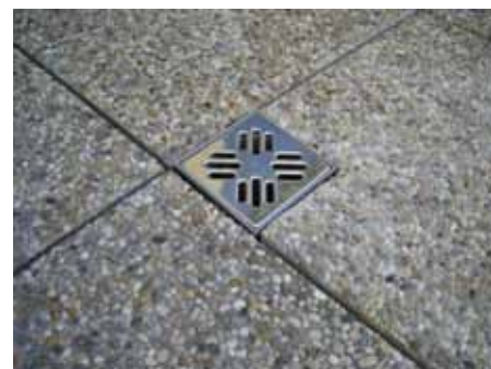
6. Засыпать гравий, уложить на него плитку, в подрамник надставного элемента вложить решетку из нержавеющей стали.
