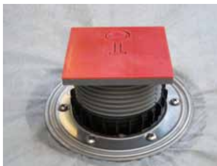
5. Фильтрующий слой зажимается между крепежным фланцем (HL83.0) и надставным элементом (HL85N), устанавливается дренажное кольцо (HL180), в которое -устанавливается надставной элемент трапа, подрезанный по уровню „чистового“ покрытия. Сверху устанавливается монтажная заглушка.
