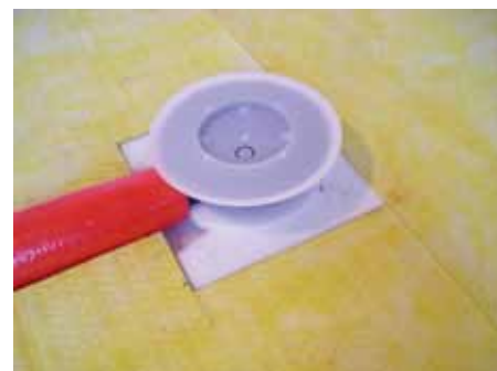
9. Уложить на плиту звукоизоляционные плиты
