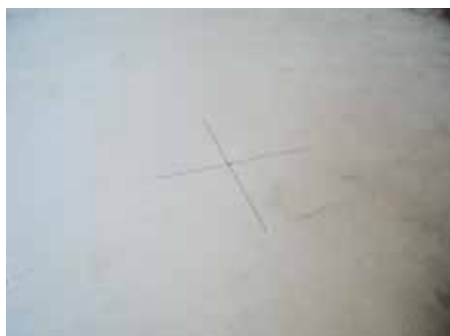
1. Отметить на плите расположение трапа
