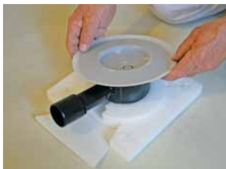
7. Установить корпус трапа с монтажной заглушкой
